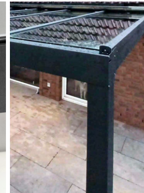
Statikträger in die Rinne integriert
